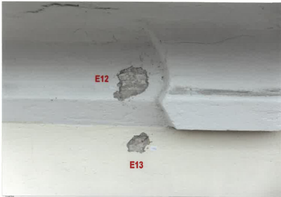
Widok odkrywek w strefie gzymsu
