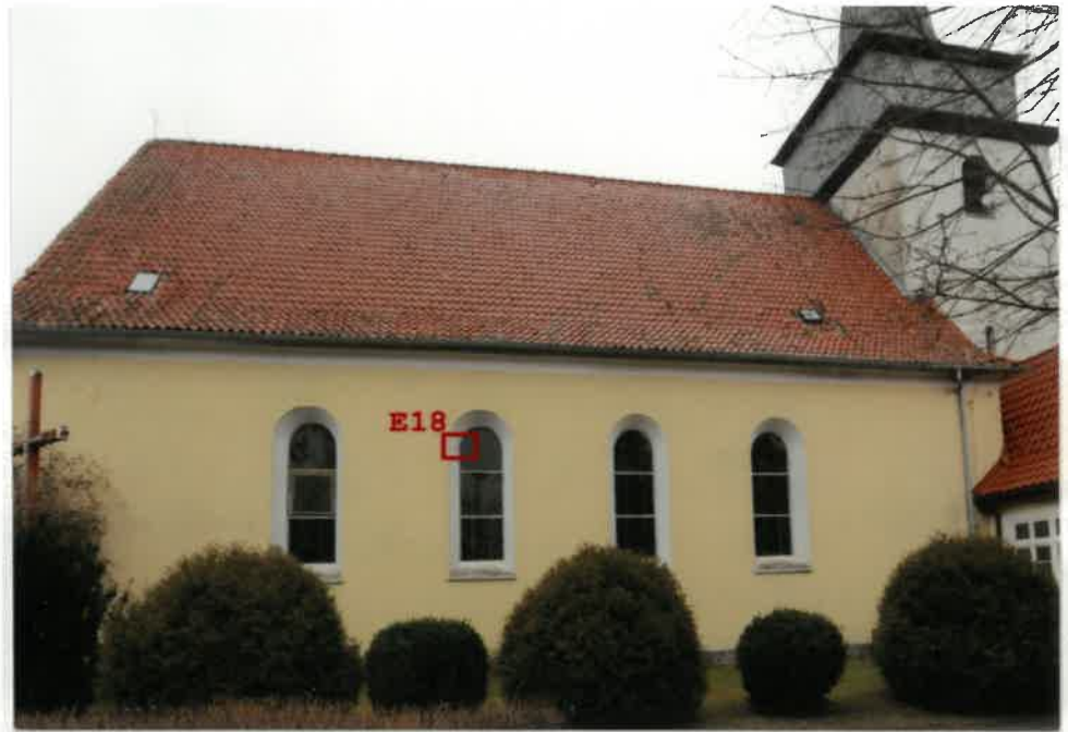
Widok odkrywki w ościeżu okna
