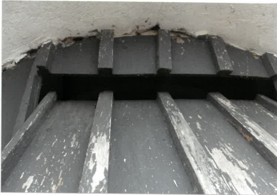
Zbliżenie żaluzji, widok niedokładności w połączeniu tynku i drewna
