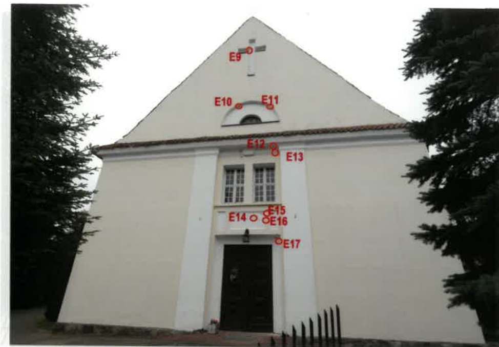
Widok elewacji szczytowej z zaznaczeniem odkrywek
