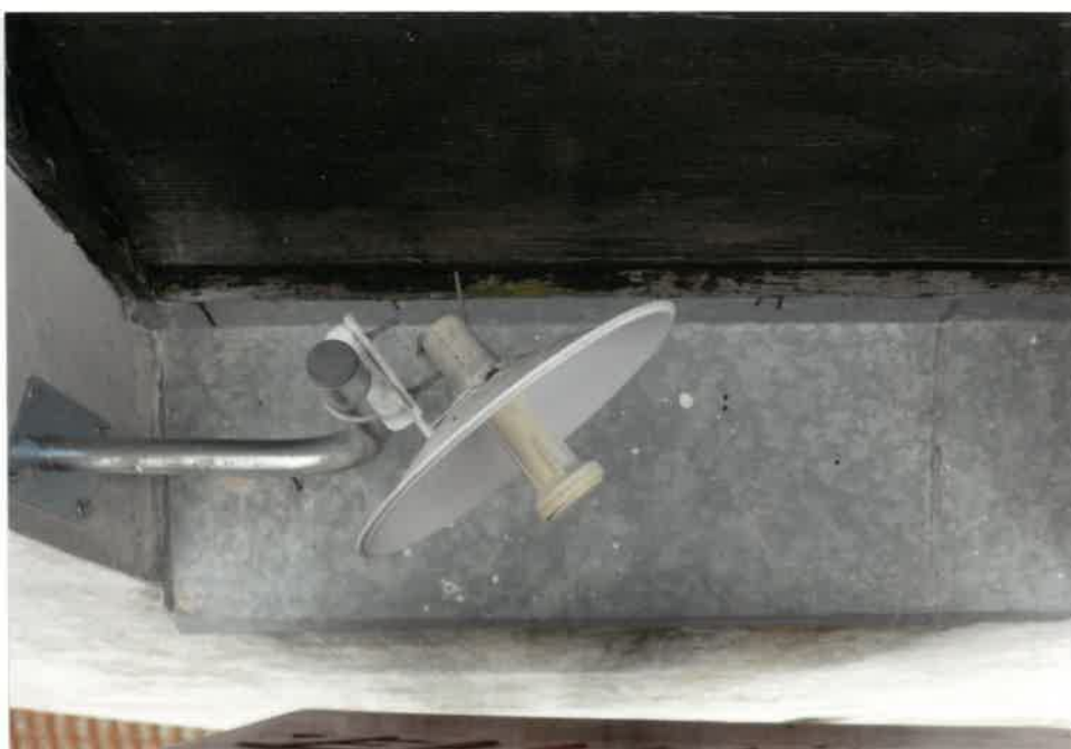
Widok wtórnego parapetu z blachy ocynkowanej.
