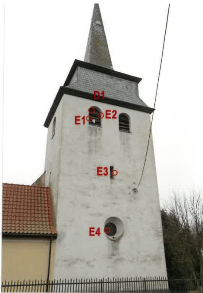
Widok elewacji wieży z zaznaczeniem miejsc odkrywek oraz zbliżenie poniżej.
