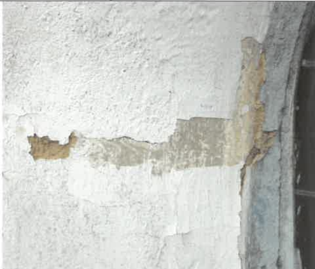
Odkrywka św/e18- ościeże okna
