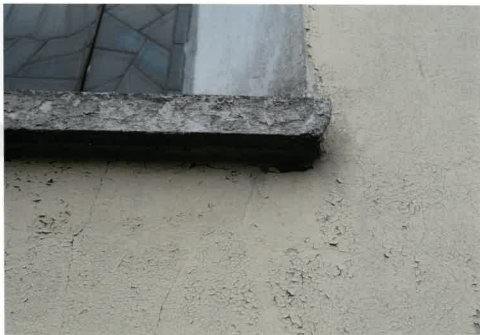
Widok fragmentu z betonowym parapetem.
