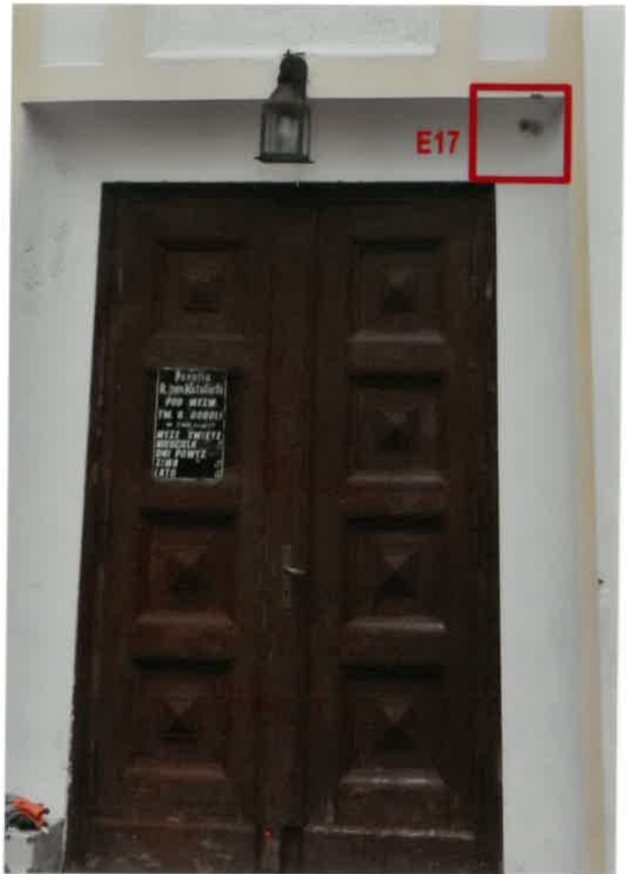
Odkrywka w partii ościeża drzwi wejściowych.
