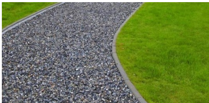
Ryc. Zdjęcia poglądowe nawierzchni zwirowej - inspiracje. Po lewej ścieżka ograniczona betonowym krawężnikiem, po prawej obrzeżem typu eko-bord. Źródło: Koncepcja zagospodarowania terenu zieleni nad jeziorem Spychowskim we wsi Spychowo, praca inżynierska autorstwa Anny Pabich.
